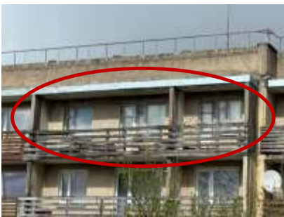
Objekta logi, lodžijas
